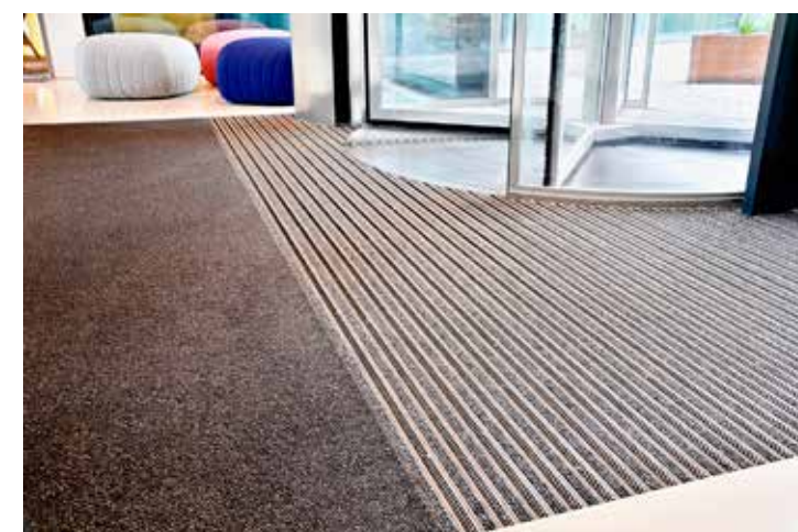
Frekventovaný hlavní vstup od ulice Plynární je osazen třemi typy čistících rohoží dle zásady postupného dočišťování od exteriéru do interiéru; viz předchozí články ERA21 #04, #05 a #06/2018.
