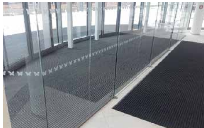
GAPA dodávala na UTB Zlín přes 60 m 2 čisticích rohoží, některé v atypickém obloukovém tvaru.
